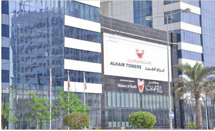
مبنى وزارة الصحة
